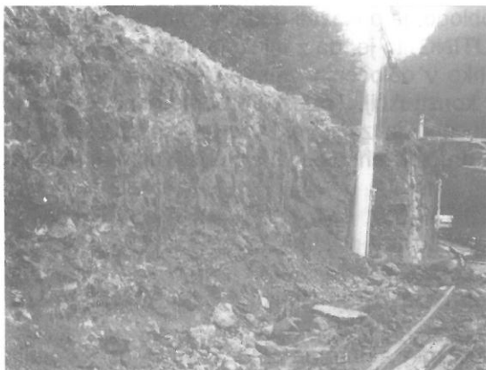
Sliki 13 in 14. Rušenje starega zidu in čiščenje površine pilotov.
